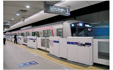
▲ホームドア設置例(みなとみらい線横浜駅)
