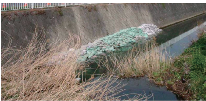
平戸永谷川の洗掘対策
