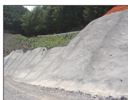
モルタル・コンクリート吹付工
