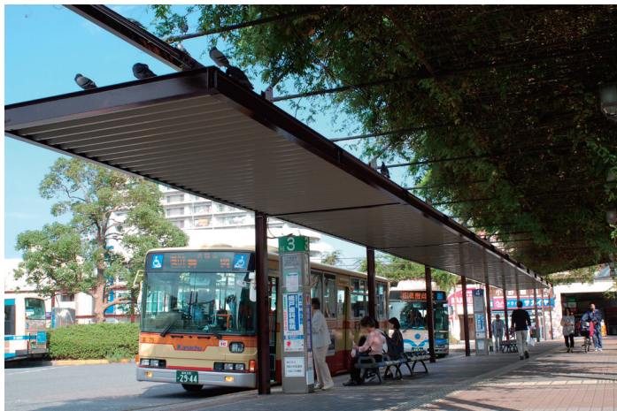
改修工事が完了した上永谷駅のバスターミナル上屋
